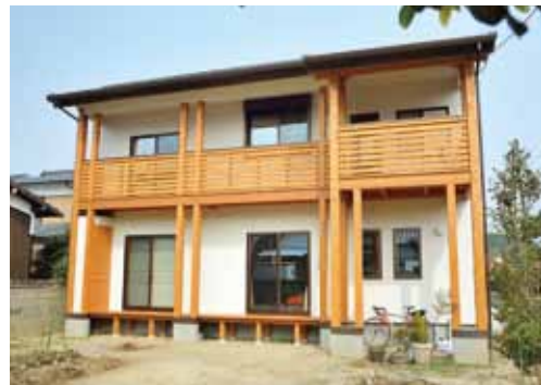
M邸の南側の外観。バルコニーは家にぴったりと付けず、少し間を空けて独立した造りに。これも室内に風を取り込む工夫のひとつ。屋根には7.5kwの太陽光発電パネルを取り付けている。
